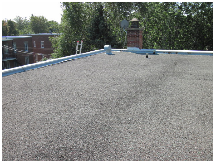
Figure 11- Vue de la toiture vers l'arrière
