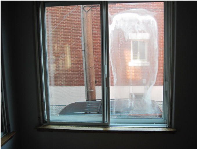
Figure 30- Condensation à l'intérieur d'un fenêtre au 6732
