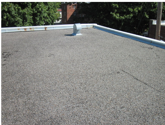
Figure 9- Vue de la toiture vers l'avant
