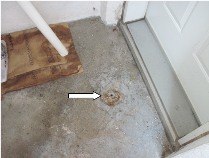
Figure 50- Drain extérieur au logement 6732A
