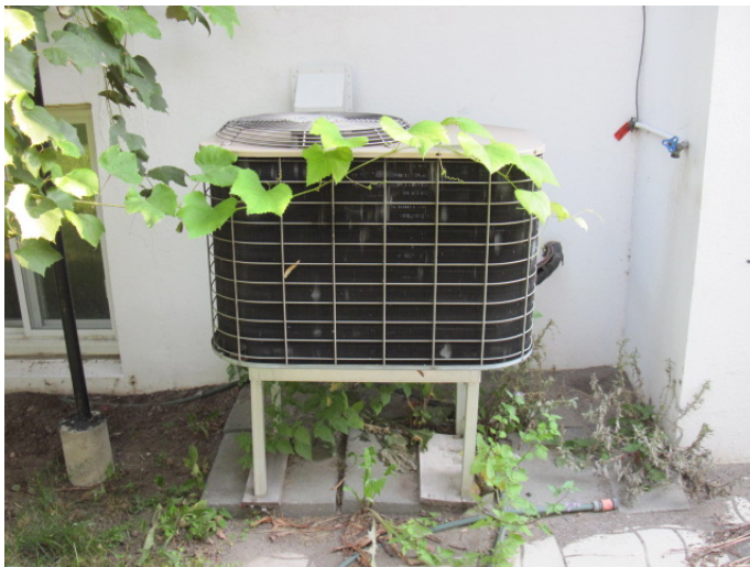
Figure 45- Thermopompe modèle BHRS0301BD, no série : 01061442, capacité 30,000BTU/hr
