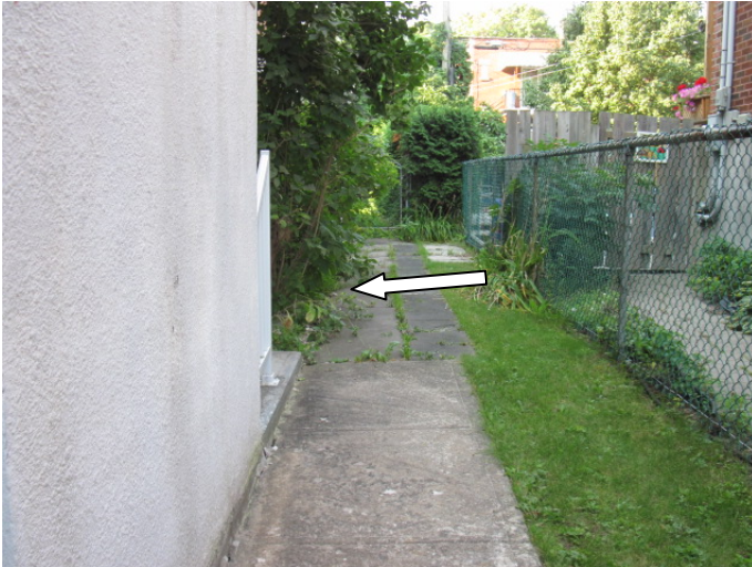
Figure 24- Pente de terrain négative côté droit
