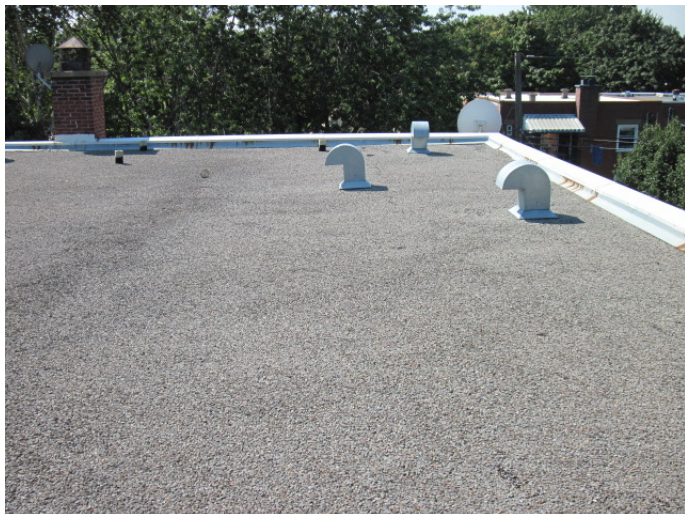
Figure 10- Vue de la toiture vers l'arrière
