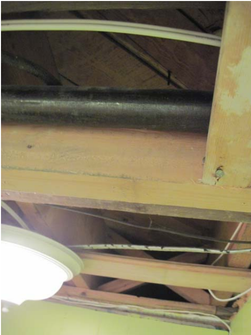
Figure 7- Vue partielle au sous-sol du 6732 de la structure de plancher
