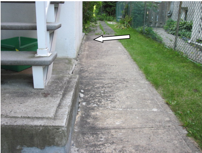
Figure 23- Pente de terrain négative côté droit
