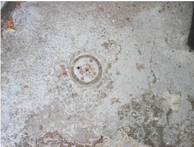
Figure 51- Un des deux drains extérieurs au logement 6734
