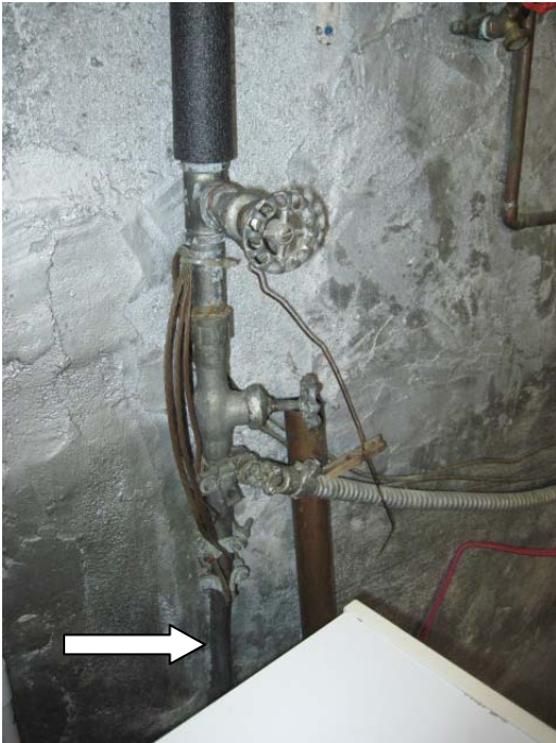
Figure 47- Entrée d'eau principale au sous-sol du 6732
