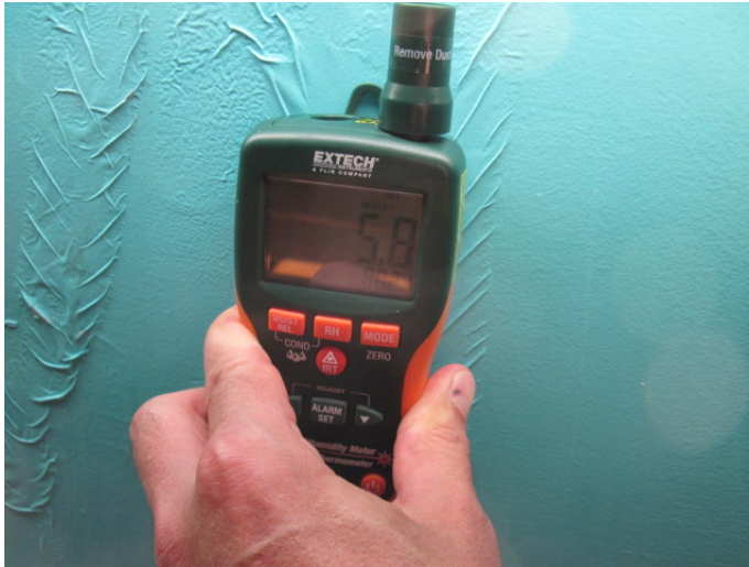
Figure 60- Lecture d'humidité au 6730 indique un niveau normal
