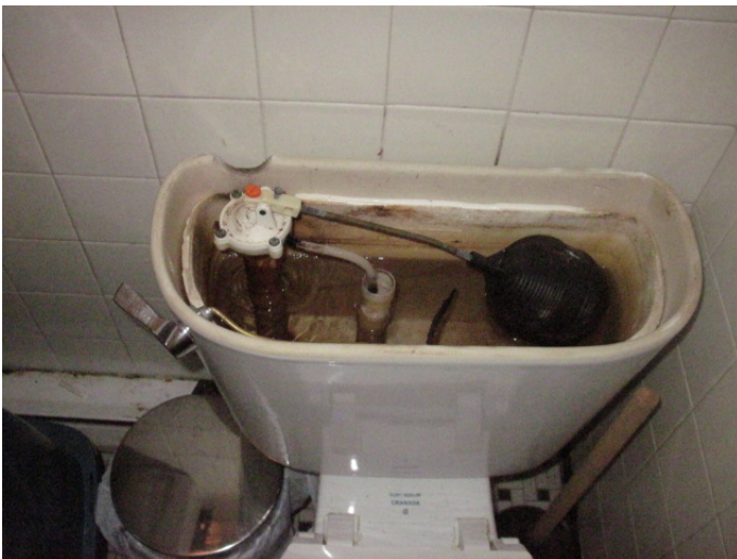
Figure 55- Mécanisme de toilette au 6736 à réparer
