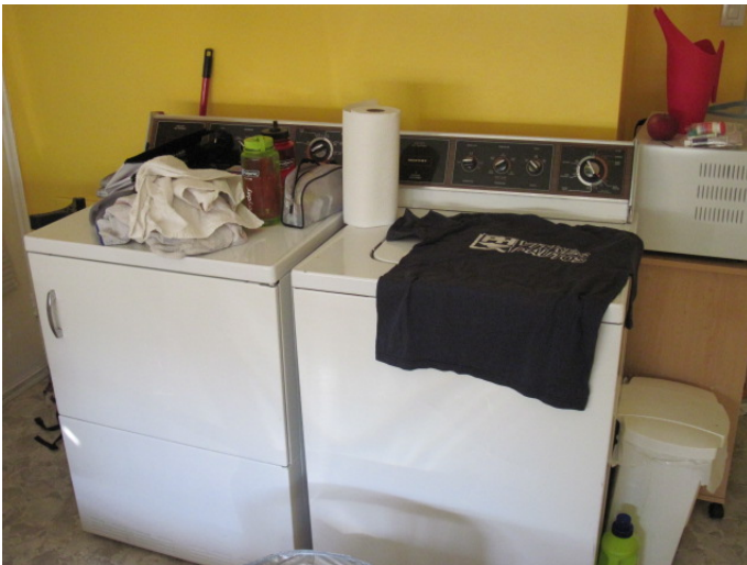
Figure 57- Installations pour laveuse/sécheuse au 6730
