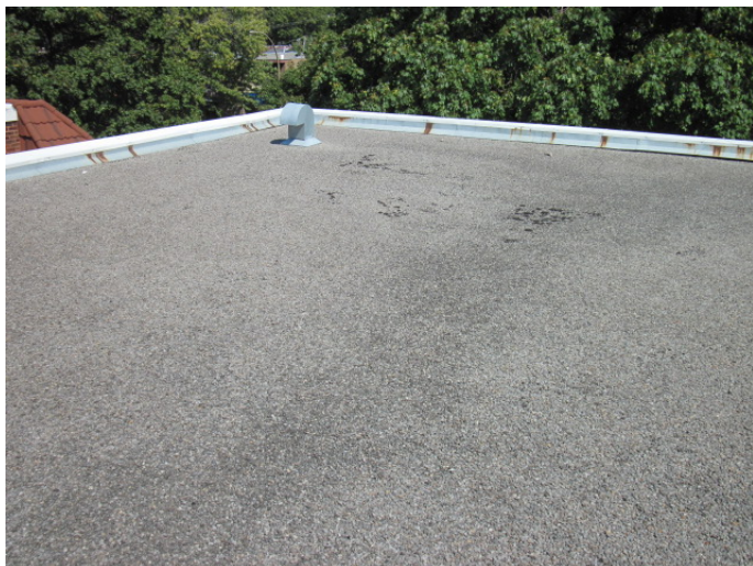
Figure 8- Vue de la toiture vers l'avant
