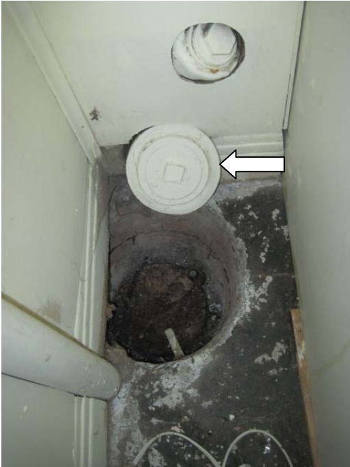
Figure 48- Regard de nettoyage du grand collecteur
